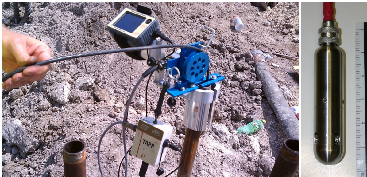
Abbildung 4: Thermal Integrity Profiler TIP (links) mit Messsonde (rechts)
