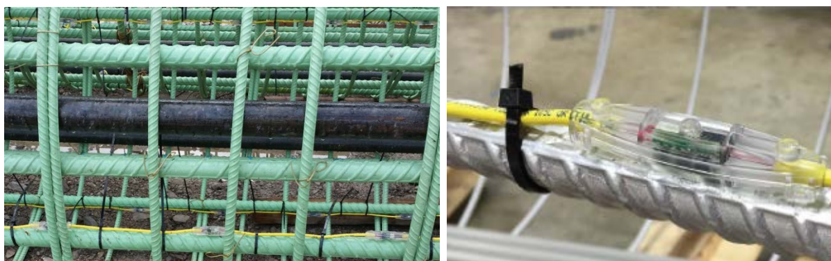
Abbildung 5: Thermal Wire® an der Bewehrung
