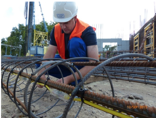
Abbildung 12: Thermische Messdrähte am Bewehrungskorb
